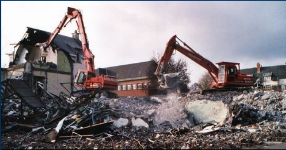
Entreprises de démolition à Marquette
