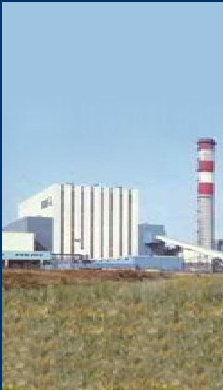
Centrale thermique de Bouchain
